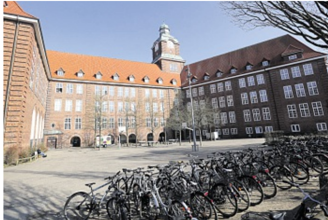
Das Alte Gymnasium verteilt die Belastung.
